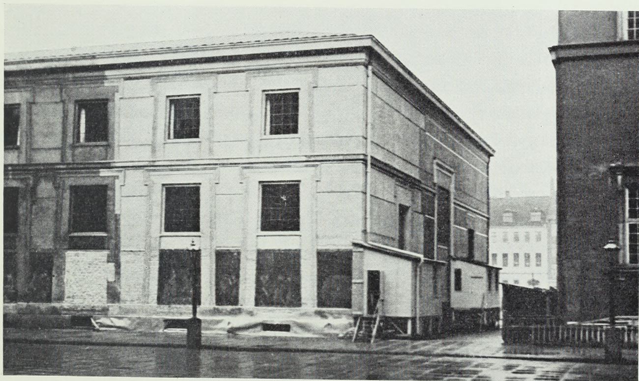
Figur 12. Museet under restaureringen. Man ser den fagvise fremadskriden af de forskellige arbejder således som beskrevet i stadsarkitektens indstilling af 25. Aug. 1950. Det forreste skur i smøgen mod slotskirken er Risebyes arbejdsstur, det bageste Axel Saltos. (Poul Larsson fot. Okt. 1952).
