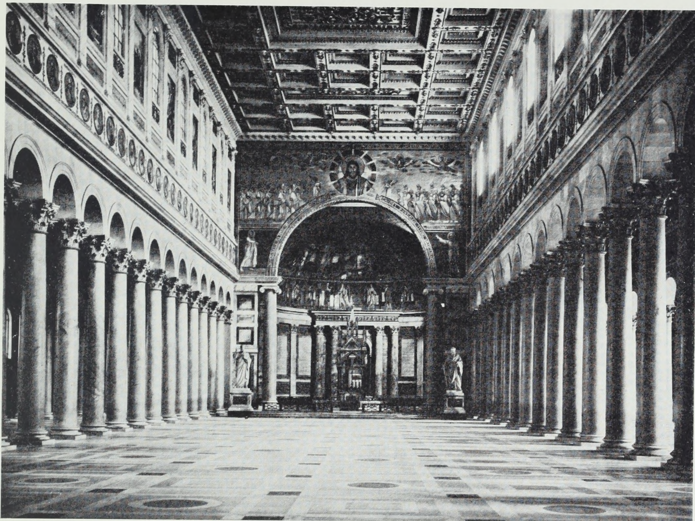
Fig. 7. San Paolo fuori le mura. Interiør efter genopbygningen.
