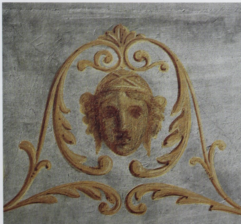
FIG. 3. Thorvaldsens Museum, rum 33. Detalje. Der er korrigeret i udmalingen af decorationen i forhold til optegningen i den våde puds.
