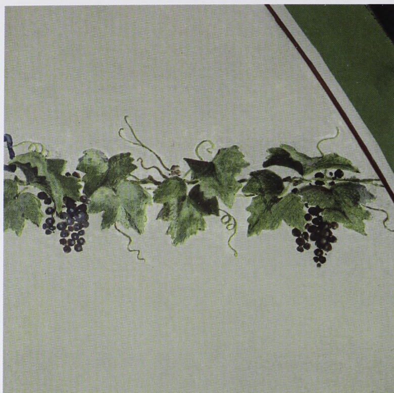
FIG. 6. Thorvaldsens Museum, rum 33. Baggrundsfarven er opmalet ind til dekorationen, hvorved den oprindelige bundfarve skimtes som en forstyrrende lys stribe rundt om ranker og druer.
