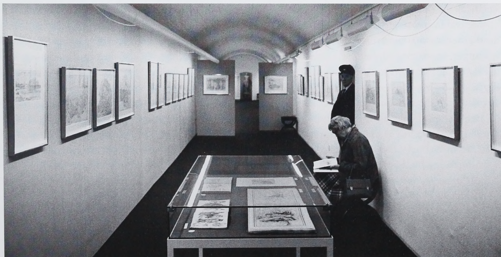
FIG. 4. Magasingangen efter ombygningen med tagren- deformede belysningsarmaturer og flytbare spanske vægge.
