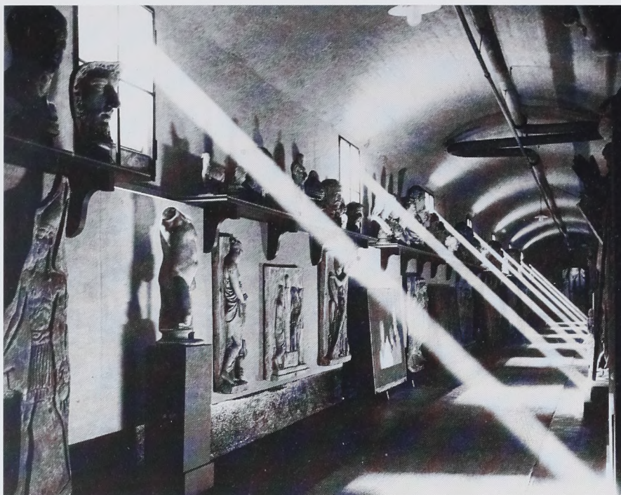
FIG. 3. Magasingangen (62) før ombygningen med Thorvaldsens afstøbningssamling efter antik skulptur. Vandrør og elektriske ledninger ses hænge frit under loftet.
