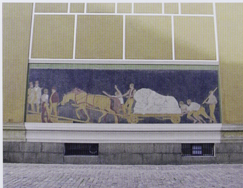
ill. 8. Frisen på forhallens facade mod Christiansborg Slot efter endt restaurering. (Foto: BK ApS)
