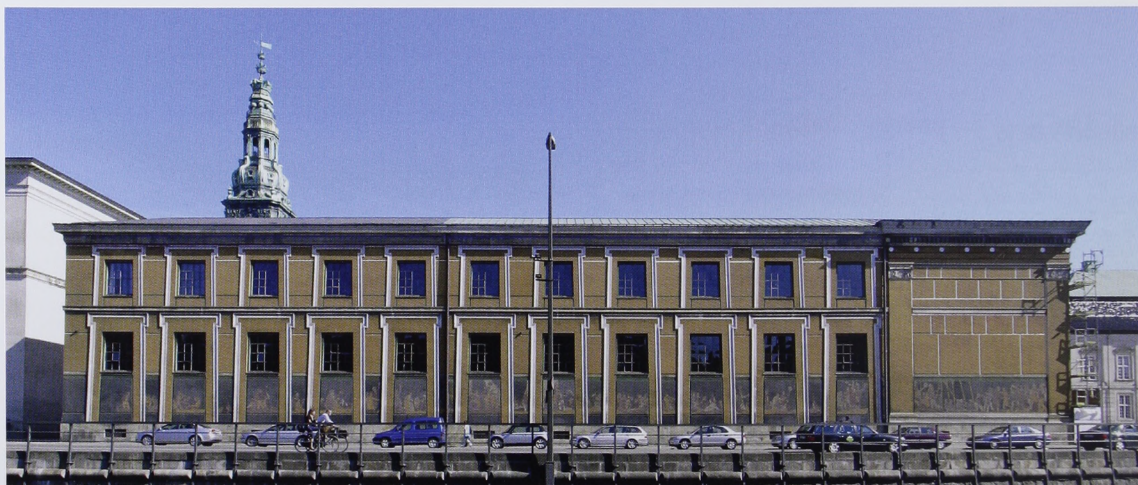
Ill. 1. Facade mod kanalen før restaurering. (Foto: BK ApS)
