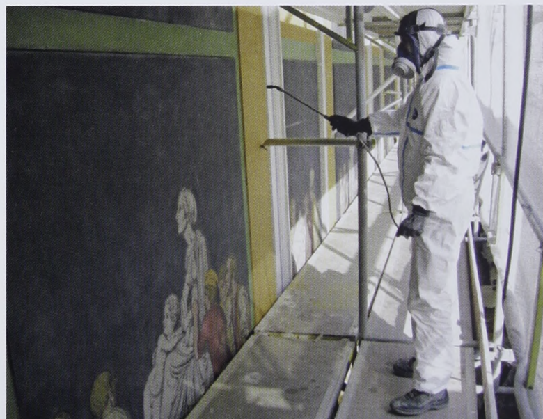
Ill. 9. Konsolidering af frisen på facaden mod Christiansborg Slot med TEOS. (Foto: BK ApS)
