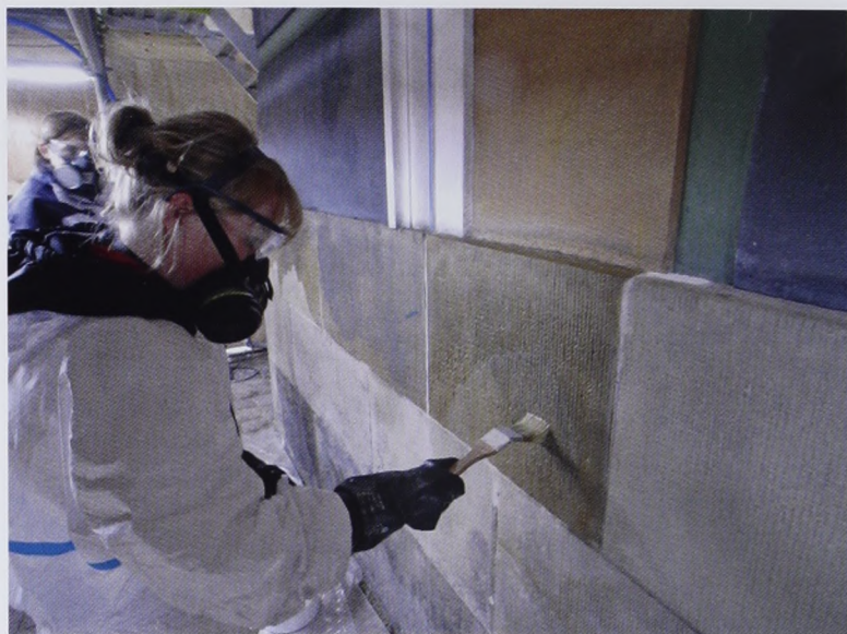
Ill. 26. Påføring af konsolideringsmidlet TEOS med pensel på udvalgte områder af kanalfacadens sandstenssokkel. (Foto: BK ApS)
