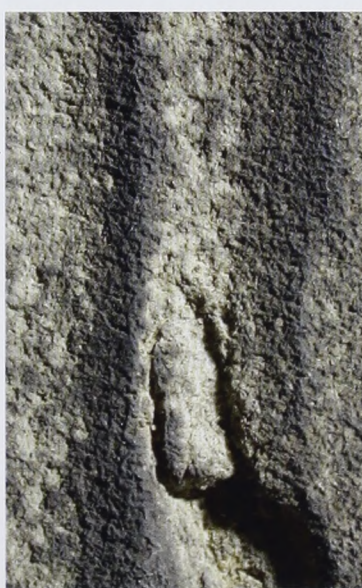
Ill. 24. Detalje af område udvalgt til forsøgsvis afrensning med partikelblæsning ( gommage ). (Foto: BK ApS)
