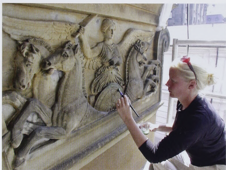
Ill. 28. Rekonstruktion af Nike-relieffets polykromering. Rekonstruktionen udføres med målsætningen at fremstille denne i en tilstand, der modsvarer bevaringstilstanden af facaden som helhed. (Foto: BK ApS)
