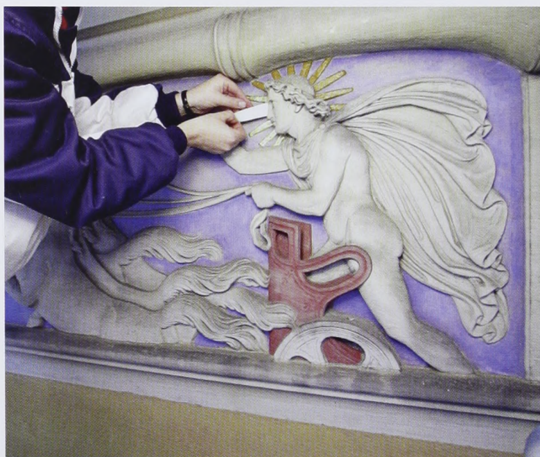
Ill. 34. Nyforgyldning af Helios' strålekrans med 23,5 karat bladguld. (Foto: BK ApS)
