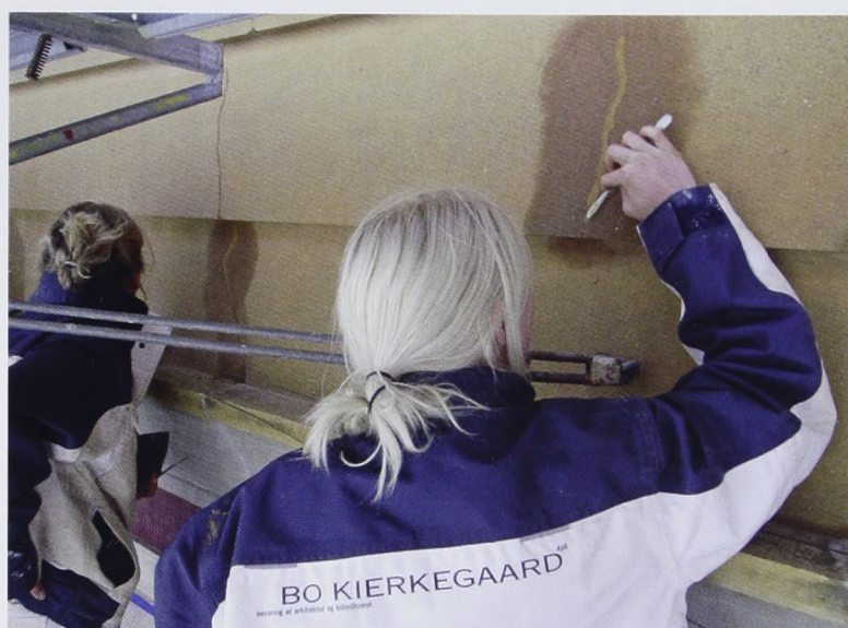
Ill. 24. Komplettering af bevægelsesrevne med restaureringsmørtel. (Foto: BK ApS)
