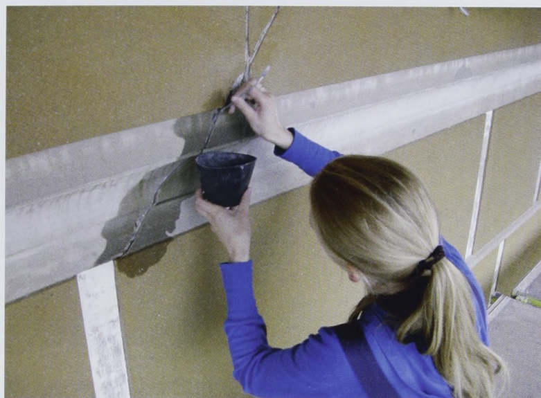
Ill. 23. Komplettering med grovpuds i udskåret bevægelsesrevne. (Foto: BK ApS)
