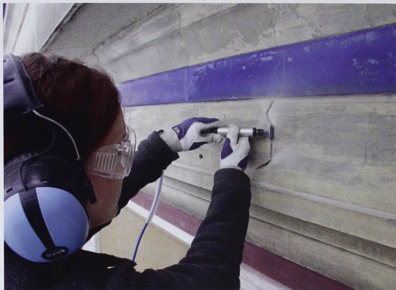
Ill. 22. Skæring af bevægelsesrevner med diamantklinge. (Foto: BK ApS)
