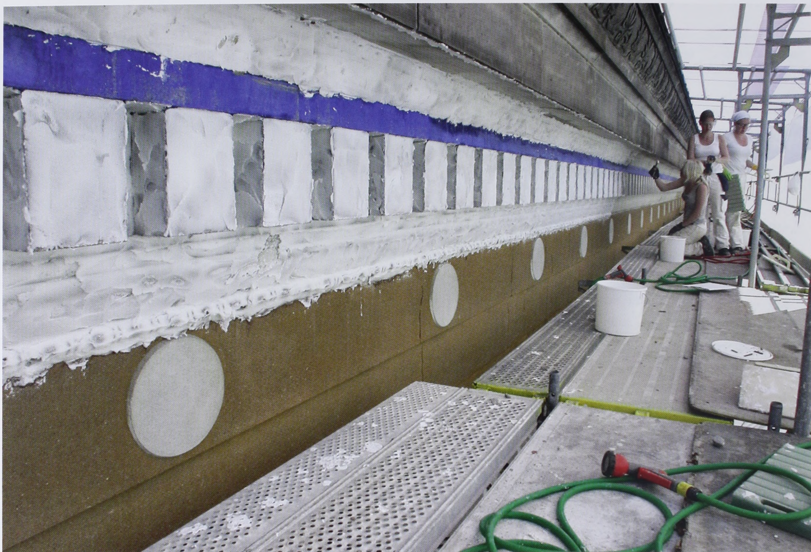
Ill. 17. Påsprøjtning af afsaltningspakning på nordfacadens kordongesims for kemisk bortrensning af gipsbelægning. (Foto: BK ApS)
