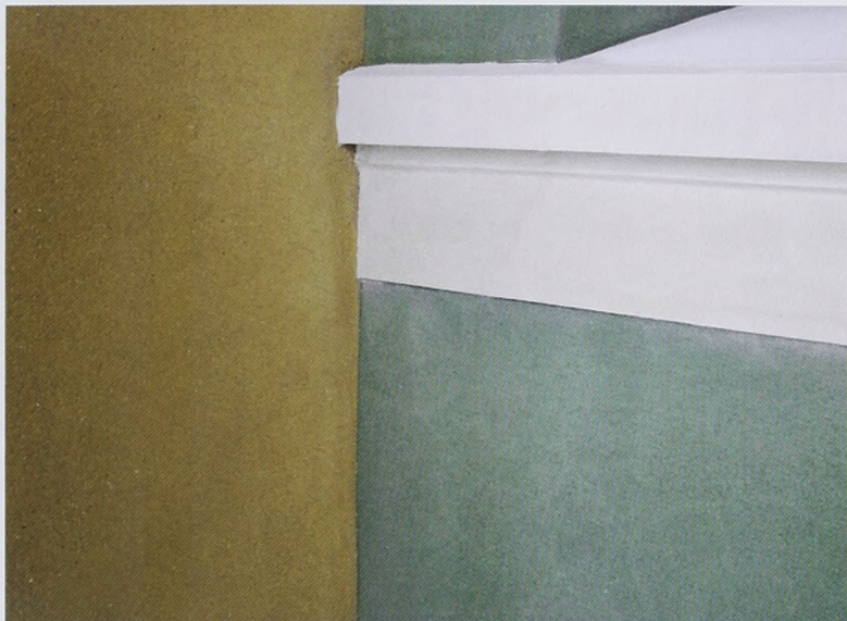
Ill. 3. Detalje af pudset vindueslysning og sålbænk på hovedfacaden efter restaureringen i 2006. (Foto: BK ApS)
