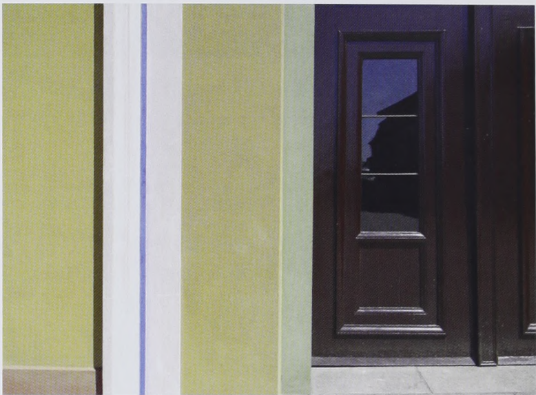
Ill. 1. Detalje af hovedfacadens pudsede flader, trukken indfatning og port efter restaureringen i 2006. (Foto: BK ApS)
