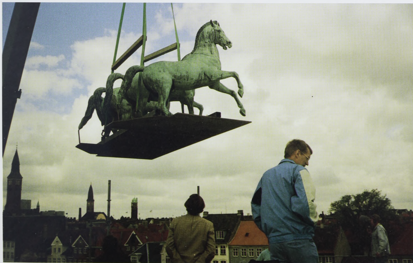
FIG. 1. Quadrigaens opsætning efter endt renovering af base og forankringer. 1990.
