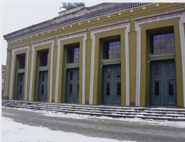
Vestfacade før istandsættelse.
