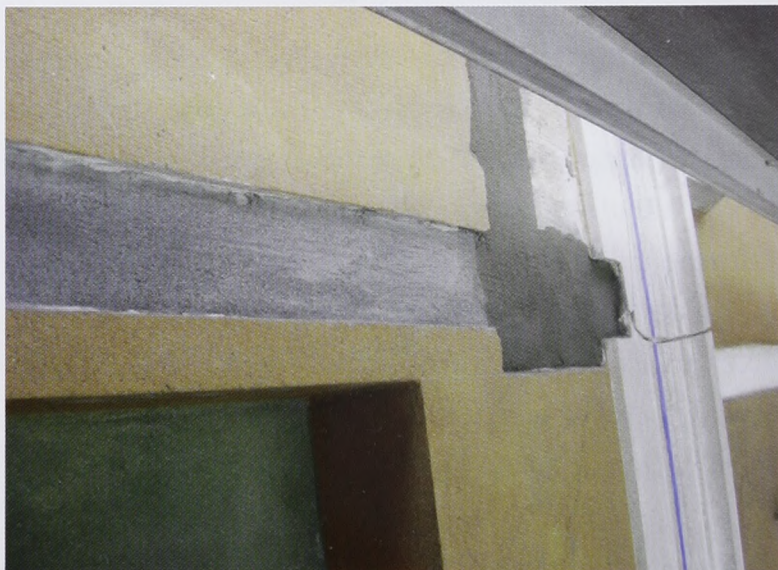
Jernprofil udsat med cementmørtel.
