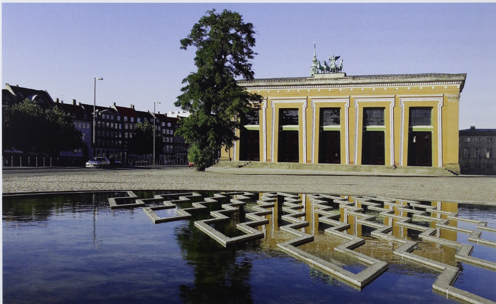
Vestfacade efter istandsættelse 2006.
