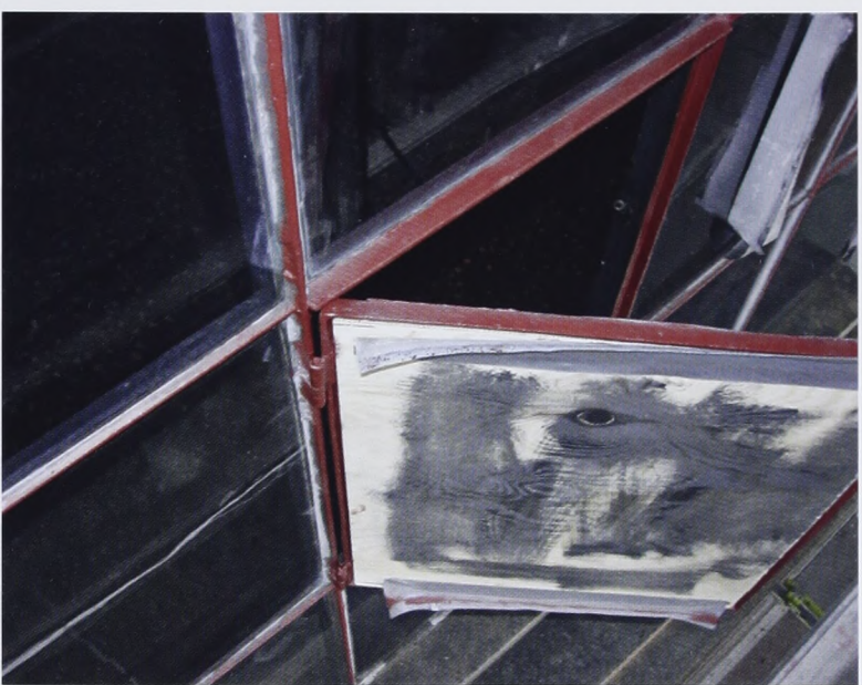
Nye stabler påsvejst mod syd.
