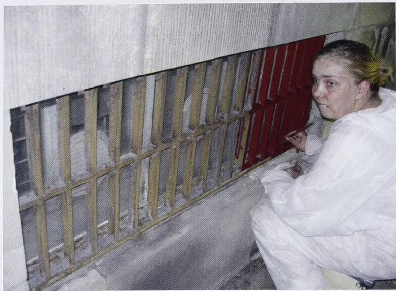
Jerngitre på nordfacade grundes.
