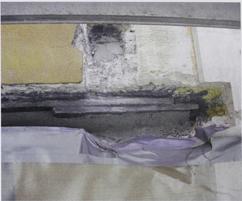
Jernprofil på nordfacade undermuret med epoxy-mørtel.
