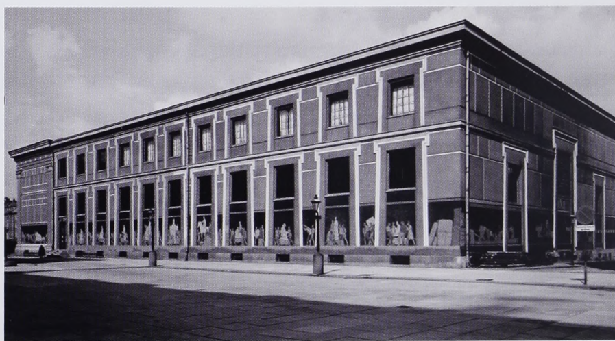
Ill. 3. Facaderne mod Christiansborg Slot og Slotskirken i 1960 efter den omfattende fornyelse og istandsættelse i 1950-59. (Thorvaldsens Museum)
