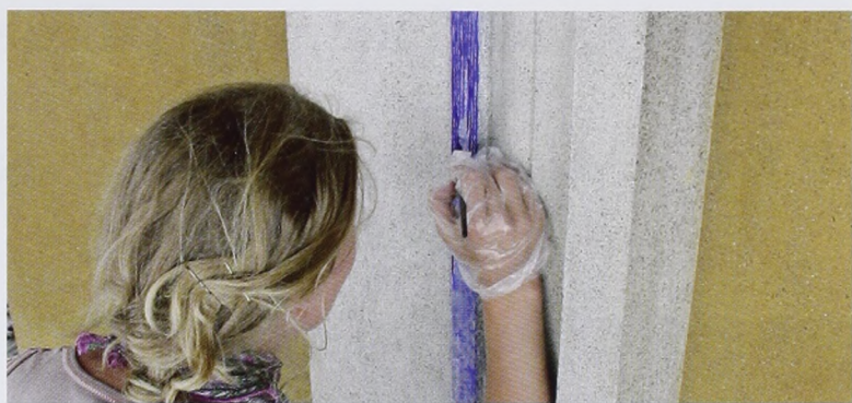
Ill. 5. Blå bort på hovedfacadens (vestfacadens) indfatninger under retouchering med trattaggio-teknik og restaureringsmaling af ultramarin i natriumsilikat. Borten blev i 1950'erne ved den store istandsættelse af gadefacaderne rekonstrueret i freskotechnik. (Foto: BK ApS)
